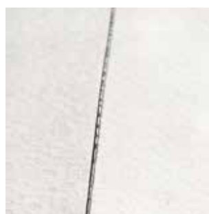
Lámina blanca con capa inferior oscura: las soldaduras destacan en la superficie blanca.
