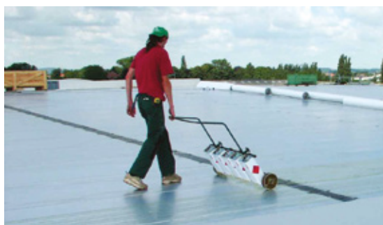
Fig 1 : Applicazione di adesivo RENOLIT ALKORPLUS 81068 con carrello
