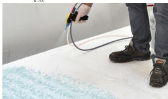
Fig 2: L'adesivo RENOLIT DUALFIX 81065 è applicato a spruzzo sulla superficie.
