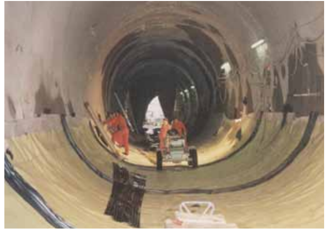
Installation de la membrane sur le fond
