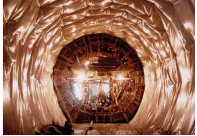
Fixation de la géomembrane par point soudure
