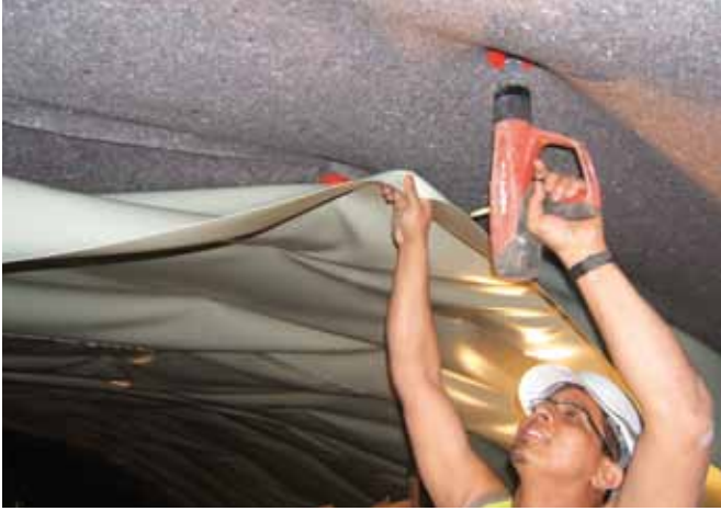
Fixation du géotextile
