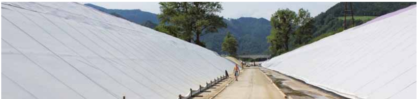
Déroulage et mise en place de la géomembrane
