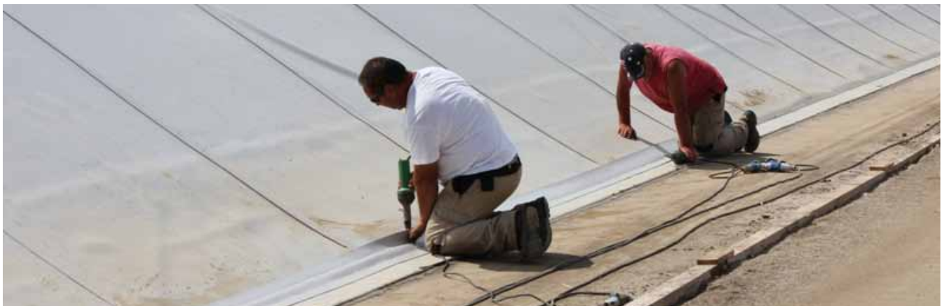
Soudure à air chaud avec double soudure
