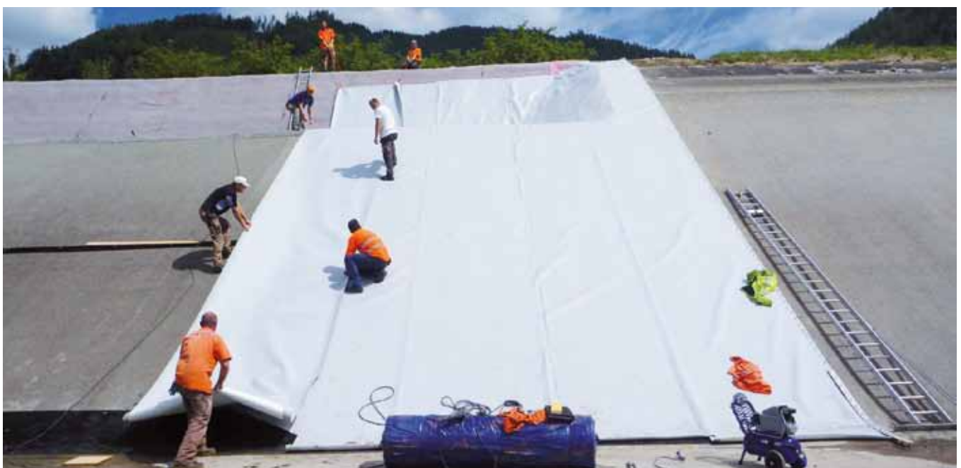
Mise en place du géotextil
