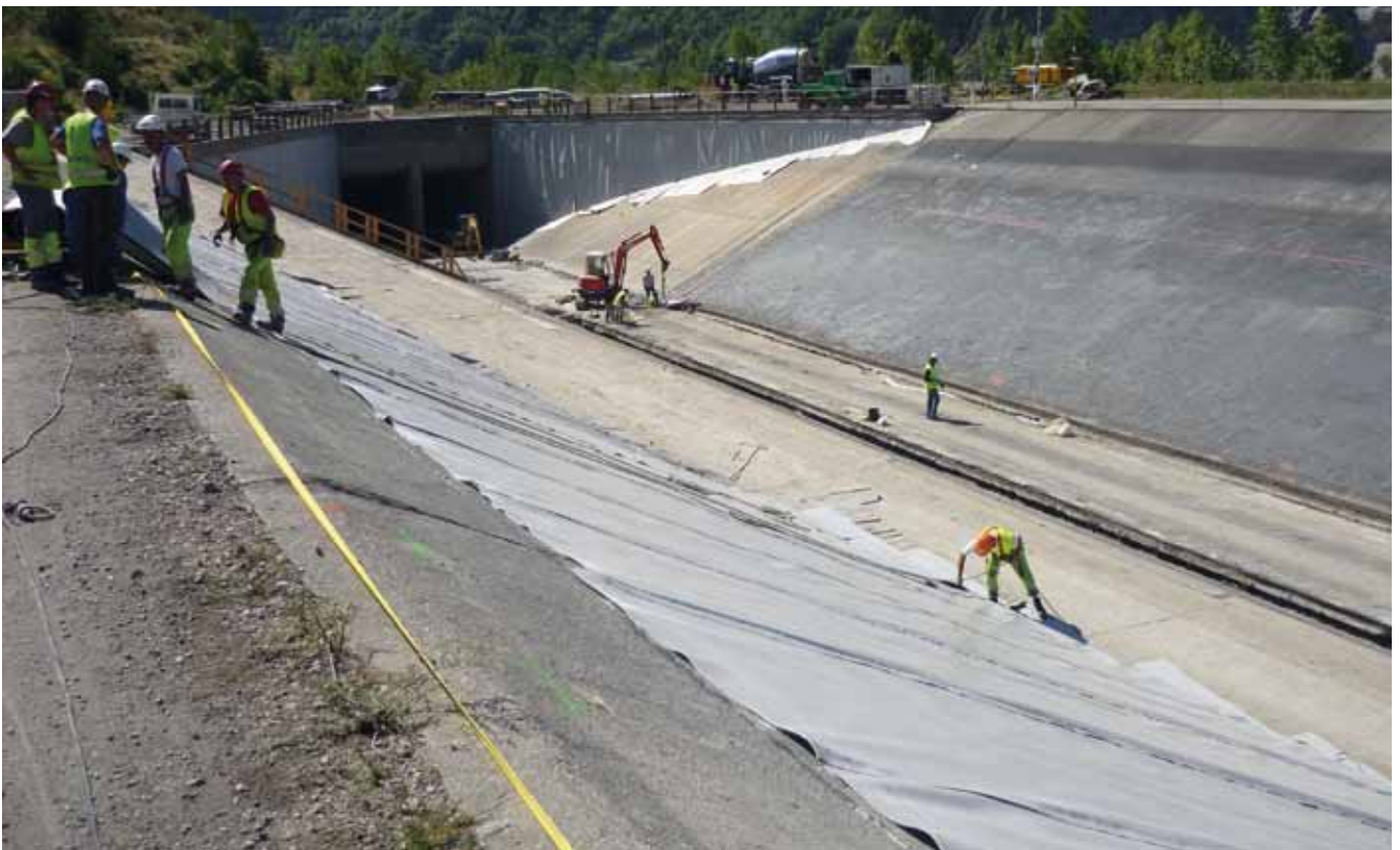
Fixation du Système d'Etanchéité au début et à la fin du canal
