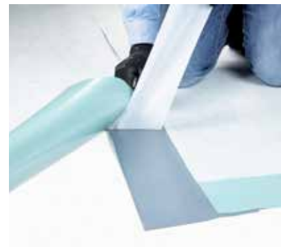
Assemblage par bande adhésive RENOLIT ALKORPRO BAND .
