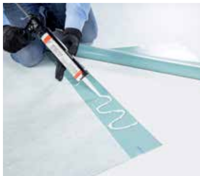
Assemblage par mastic-colle RENOLIT CEM 805 .
