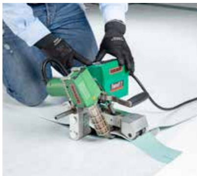
Assemblage par soudure thermique.
