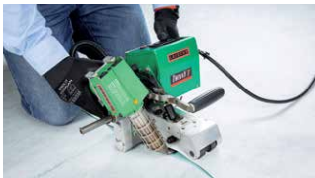
Giunta tramite termosaldatura
