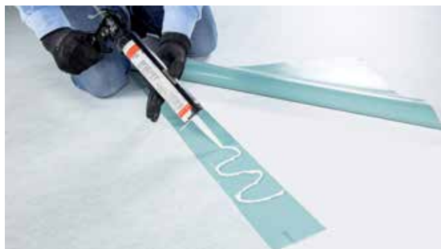
Giunta con adesivo RENOLIT CEM 805
