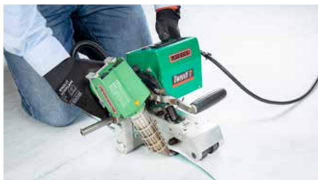
Unión mediante soldadura térmica
