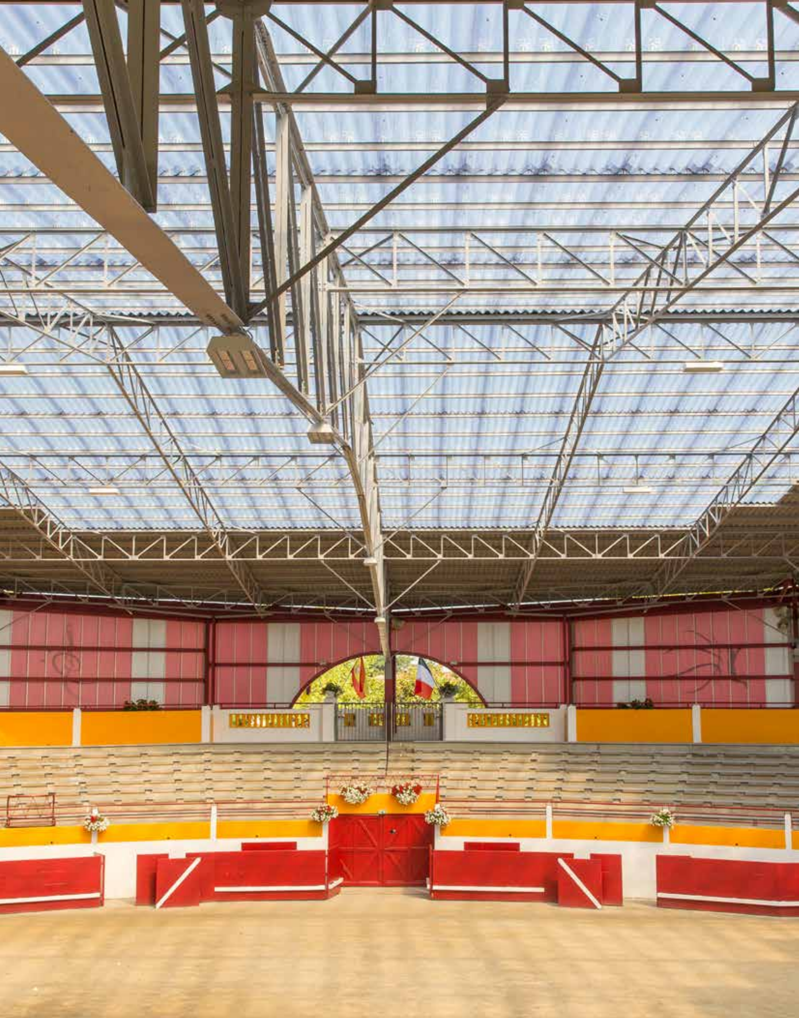
COUVERTURE TOTALE EN PLAQUES RENOLIT ONDEX - ARÈNES DE POMAREZ (40) / FRANCE
