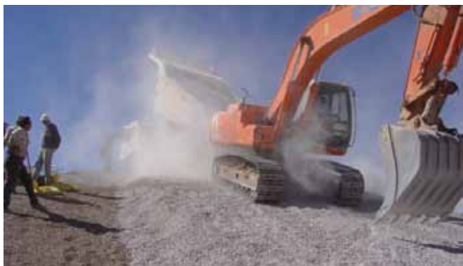
Mise en place de la couche de drainage
