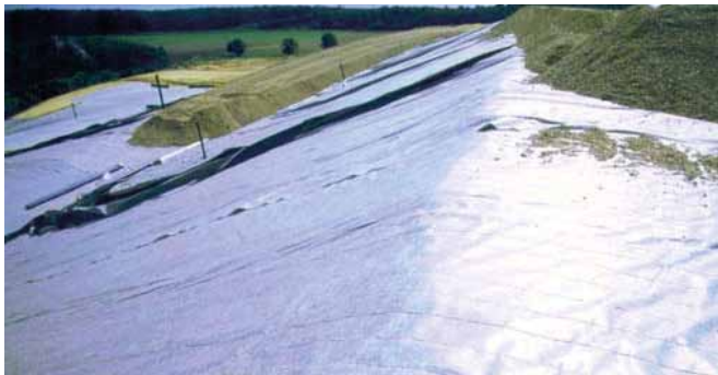
Protection de la couche de gravier de drainage
