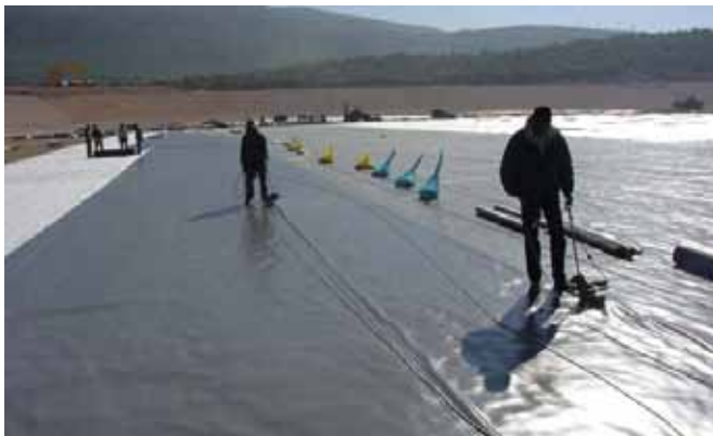
Soudure de la Géomembrane
